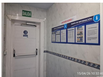
Emergency door + info.jpg
